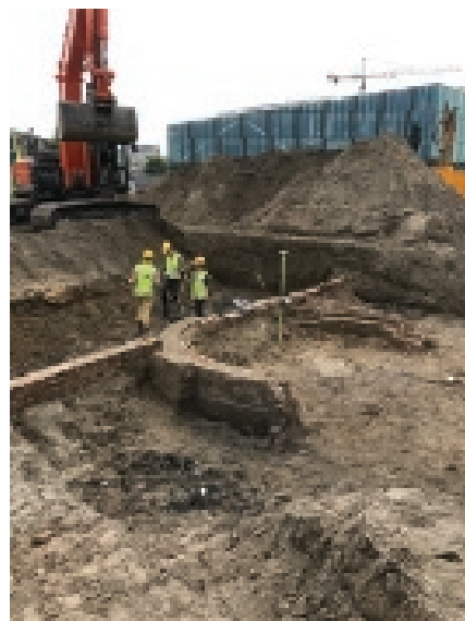
7 Werkzaamheden ter hoogte van de draaischijf met op de achtergrond het huidige stationsgebouw annex stadskantoor. (FOTO AMD)
