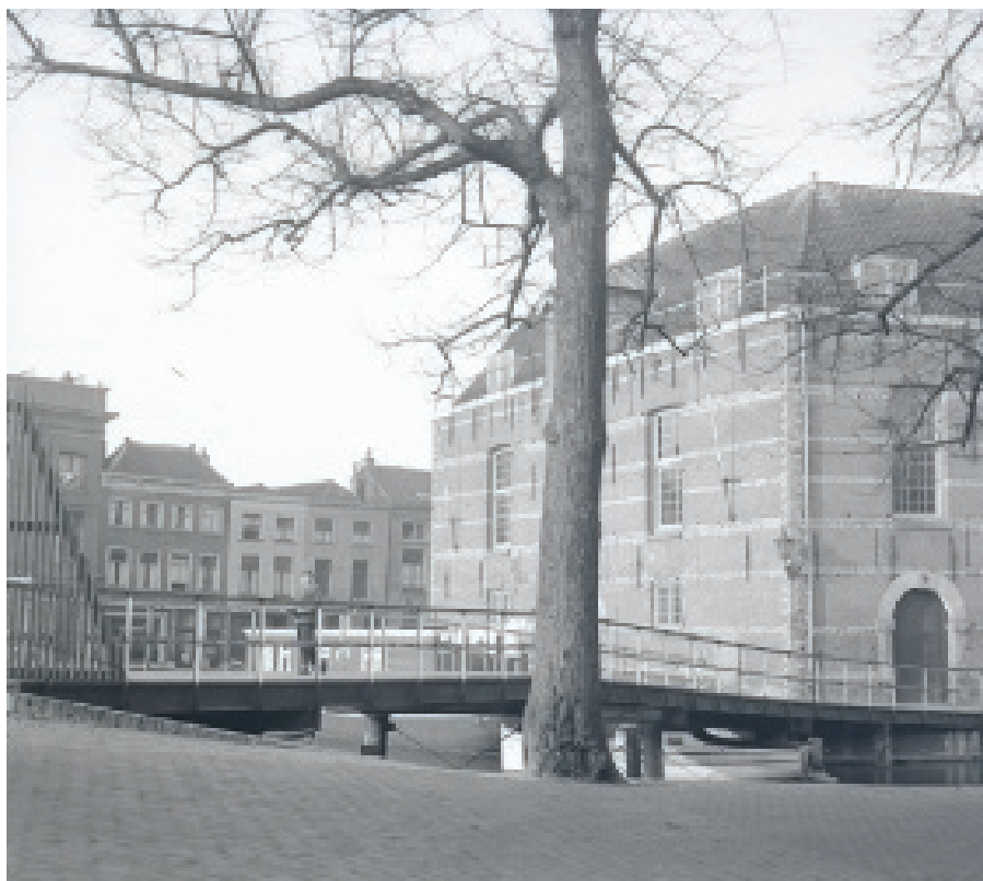
Al eerder lag er een brug bij het Armamentarium. Tijdens de Tweede Wereldoorlog bouwde de Duitse bezetter een noodbrug van de Lange Geer naar het Armamentarium, deze werd in 1954 afgebroken. (SAD 124372, FOTO OPENBARE WERKEN)
