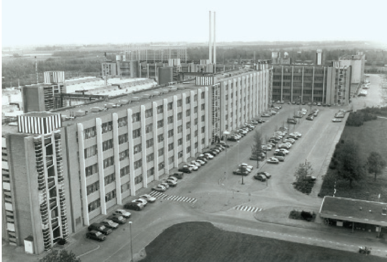
4 Het TNO-complex aan de Schoemakerstraat gezien vanaf de flat aan de Professor Evertslaan naar het zuiden, 1983. (SAD 7195, FOTO TON KERKLAAN)
