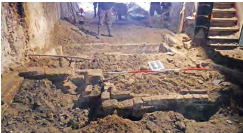
Impressie van het inpandige muurwerk.
