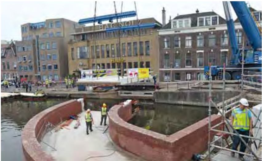
(11 juli) Het plaatsen van het brugdek van de brug bij de Hooikade.
