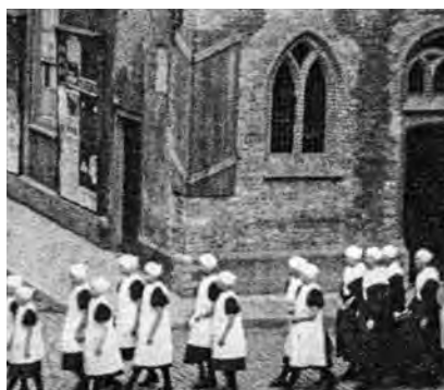
7. De kapel na de restauratie van de voorgevel. De zijgevels zijn nog niet gerestaureerd. De nis op de boek is wel opnieuw aangebracht, maar met planken afgetimmerd. (Zie voor de complete foto blz. 155)
