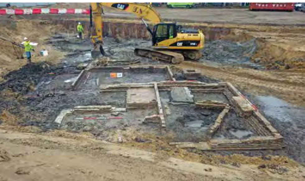
De funderingen van de huizen zoals ze blootgelegd zijn om in te meten.
