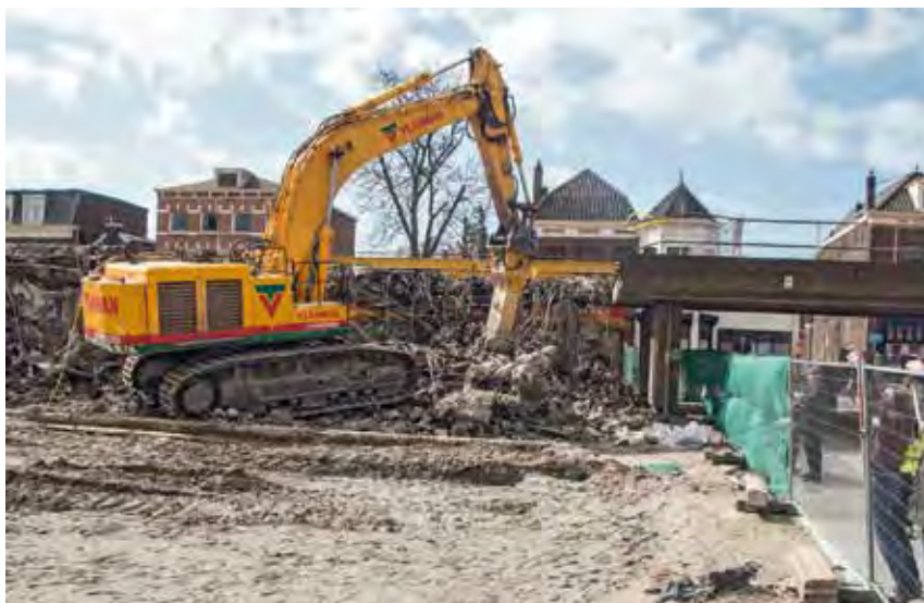
(1 april) Er wordt een eerste bres geslagen in het treinviaduct.
