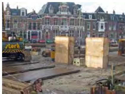
Twee pijlers resteren als herinnering aan het viaduct.
