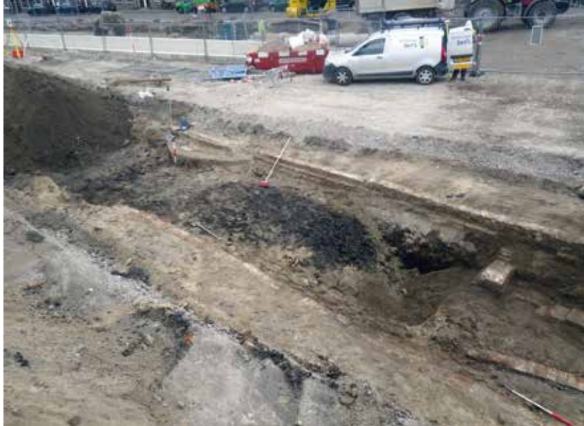
Het eerste spoor en de draaiplaat.
