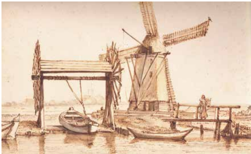
Een windas of overtoom, waarmee kleine schepjes over de dam werden getrokken (tekening van Anthony van Borssom).
