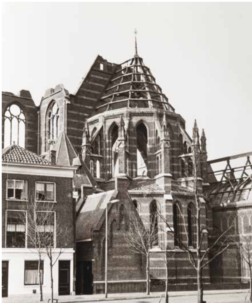
8 Het priesterkoor met de bijzondere lichtboogconstructies tijdens de sloop in 1974.
