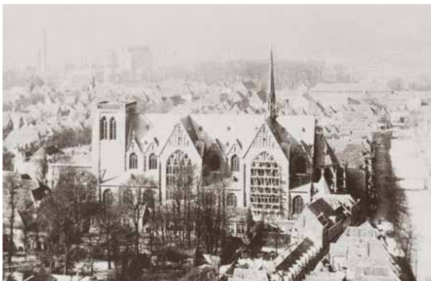
1 De zuidzijde van de Sint-Hippolytuskerk gezien vanaf de toren van de Nieuwe Kerk in 1891.
