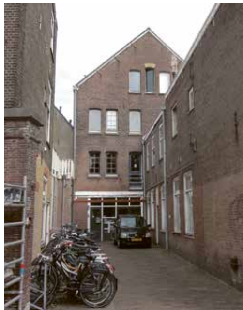
16 Het gebouw van de voormalige karottenfabriek aan de Lange Geer maakte ooit deel uit van plateelbakkerij De Grieksche A . (FOTO AUTEUR).
