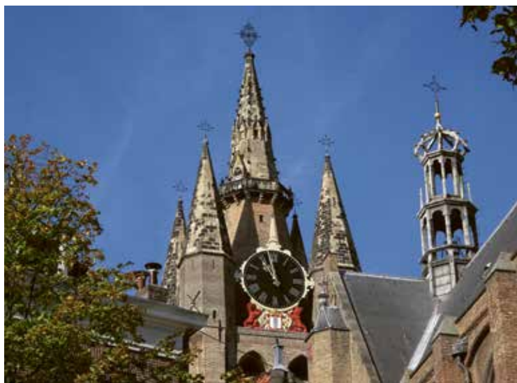
De gerestaureerde toren van de Oude Kerk. (FOTO: DENNIS VAN VEEN, VELDMAN RIETBROEK ARCHITECTEN).
