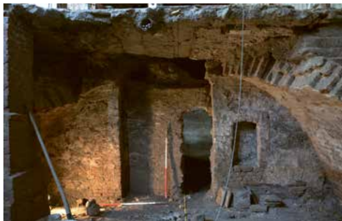
4 Oostgevel van de veertiende-eeuwse kelder met tongewelf. (FOTO: ARCHEOLOGIE DELFT).
