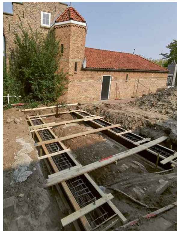
14 De tunnel bij de Sint-Huybrechtstoren blootgelegd. (FOTO AMD)
