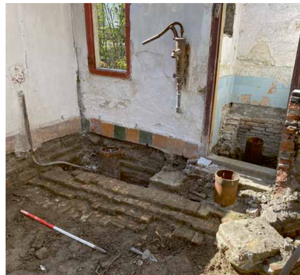
4 De gemetselde fundering binnen de karnschuur. (FOTO AMD)
