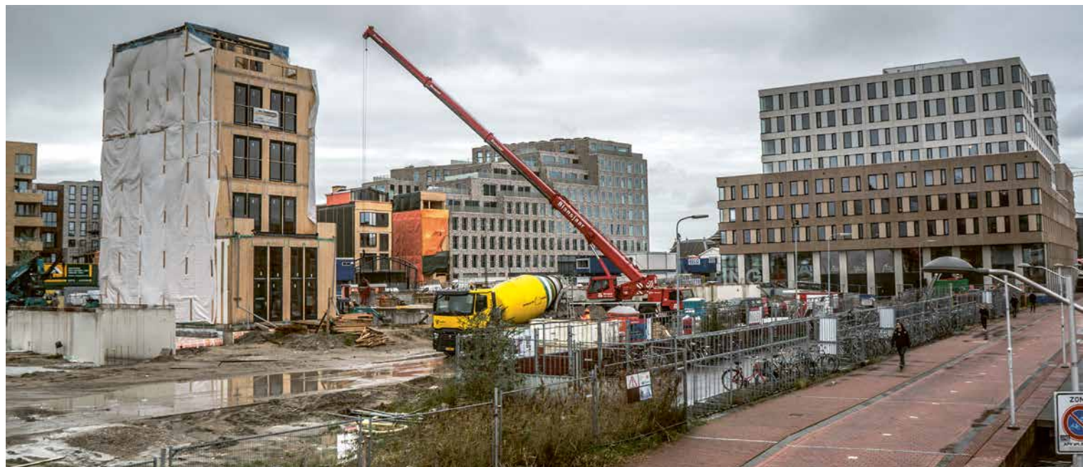
2 november: Olthuis' huis in aanbouw. (FOTO FRED LEEFLANG)
