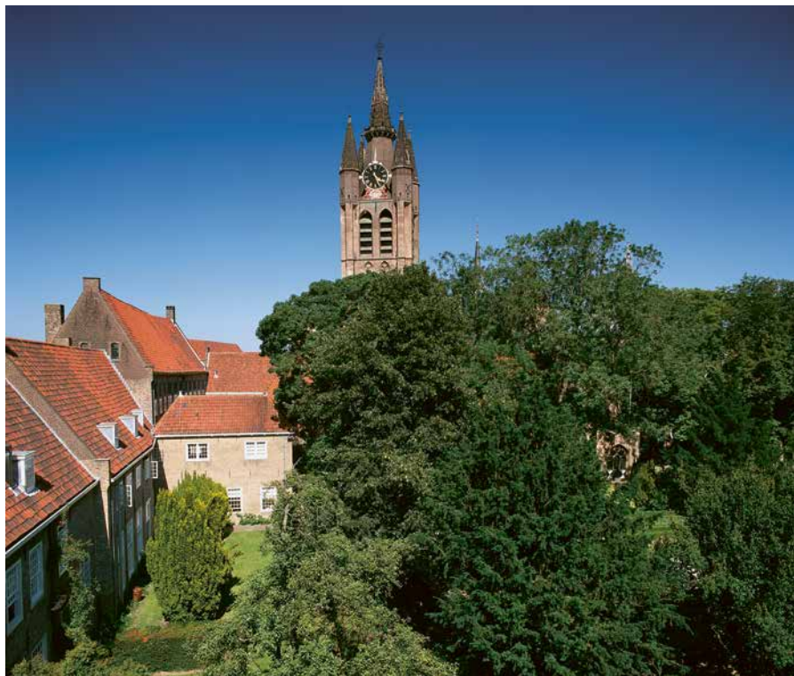
Renovatie van het Prinsenhofcomplex, inclusief de groene Prinsentuin, blijft de gemoederen bezighouden. (FOTO THIJS TUURENHOUT)
