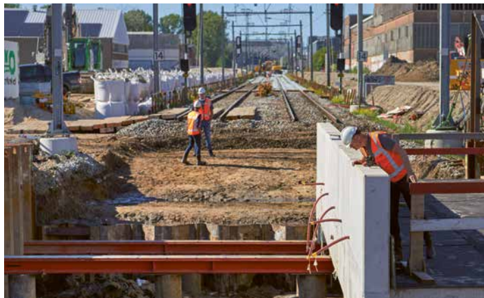
20 juni: Het plaatsen van het tunneldek bij station Delft Campus. (FOTO VINCENT BASLER)
