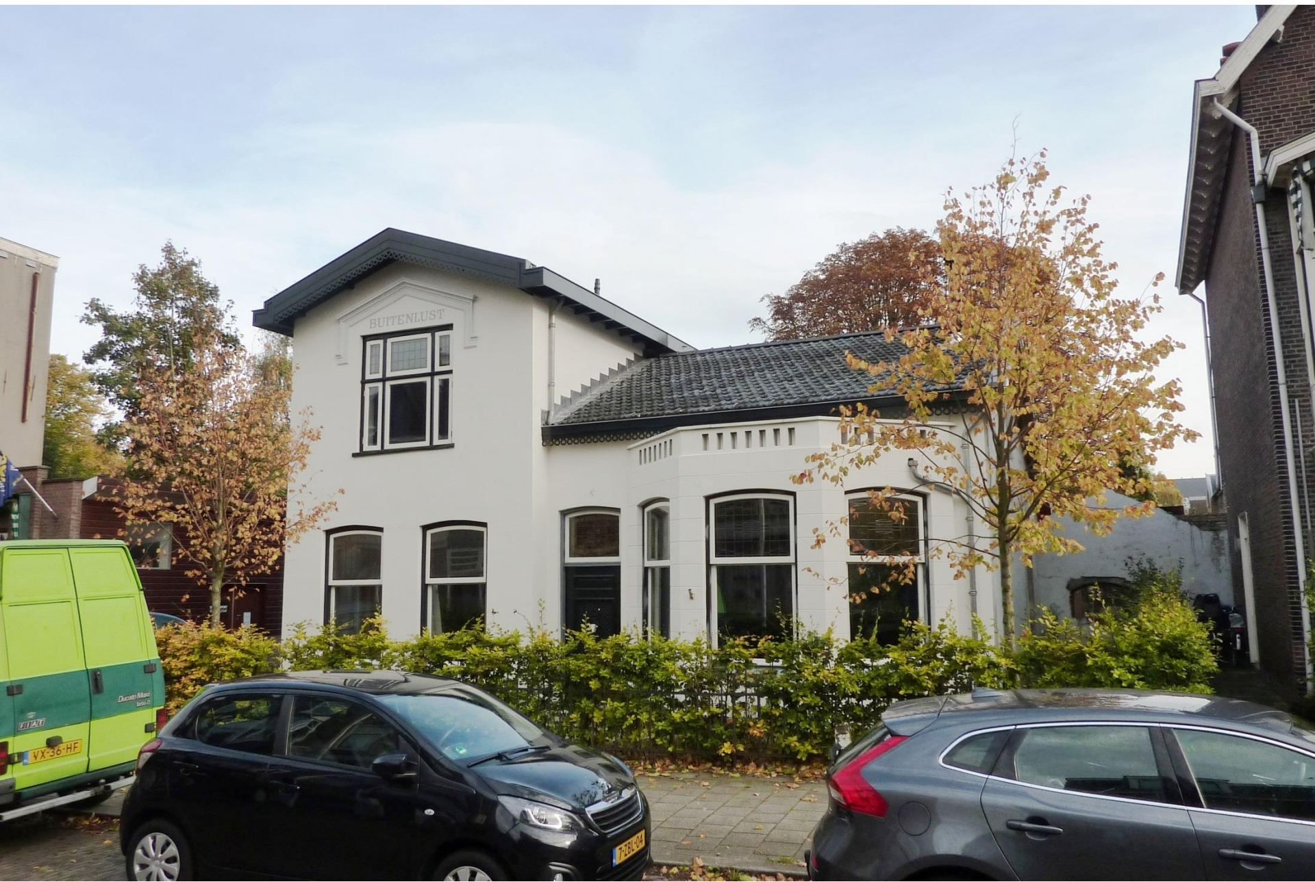
Rotterdamseweg 13, restauratie 'Villa Buitenrust'
