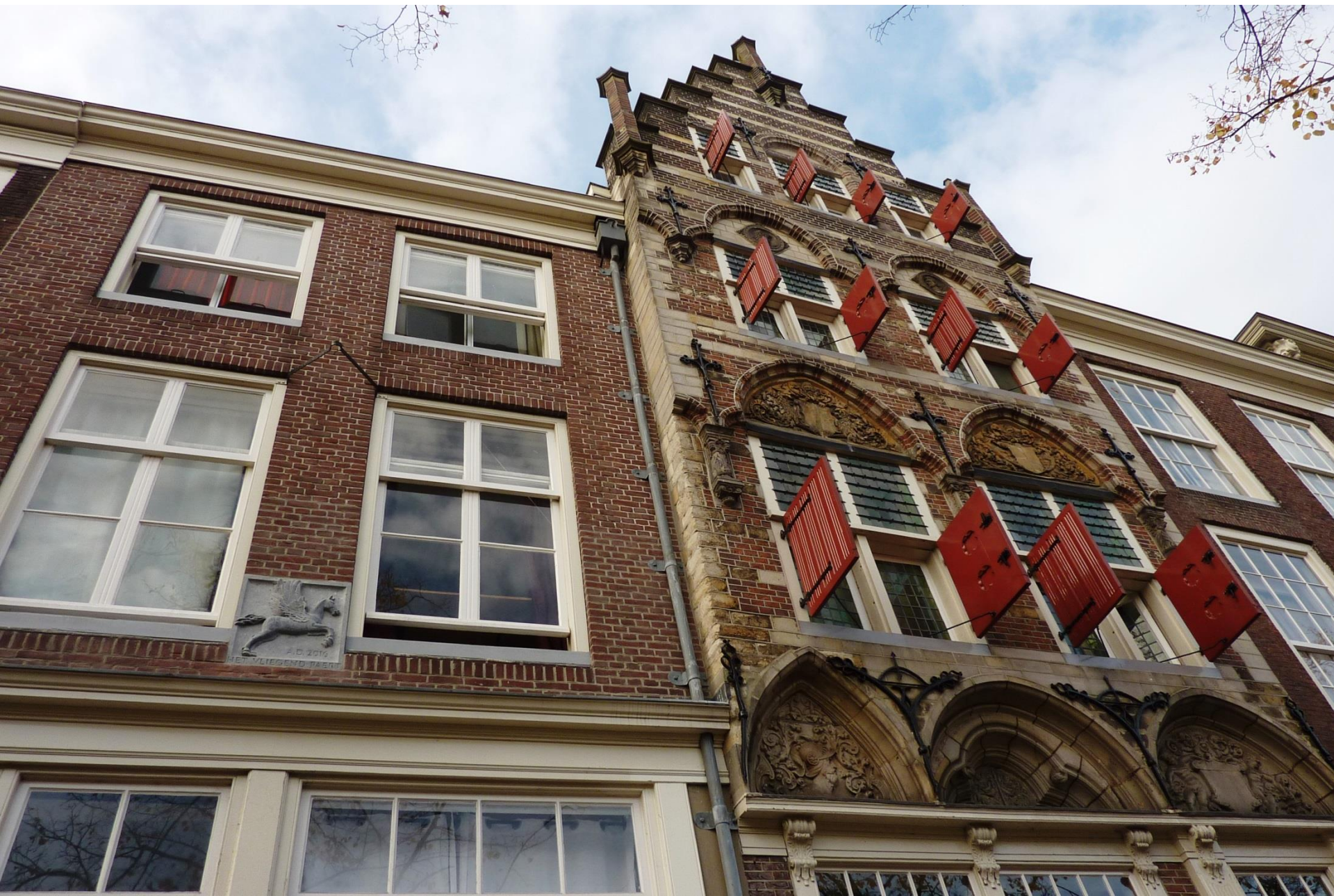
Koornmarkt 79-81, aanbrengen gevelsteen
