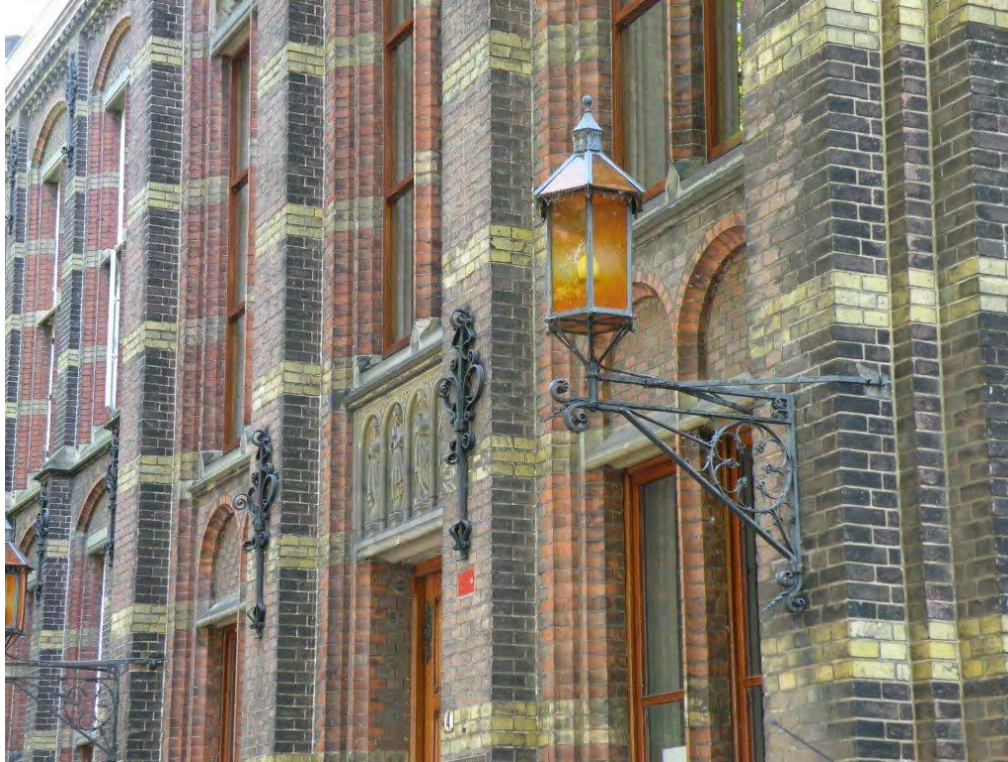
Neogotische architectuur uit het eind van de 19 de eeuw: het gebouw Kanaalweg 4.
