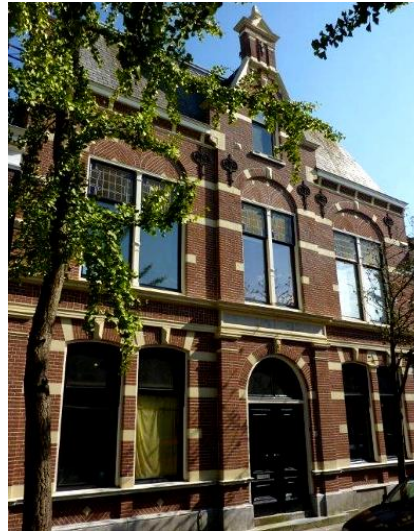
Nominatie 4: De heer H.J. de Graaf, voor de gevelrestauratie van het pand Raamstraat 45.
