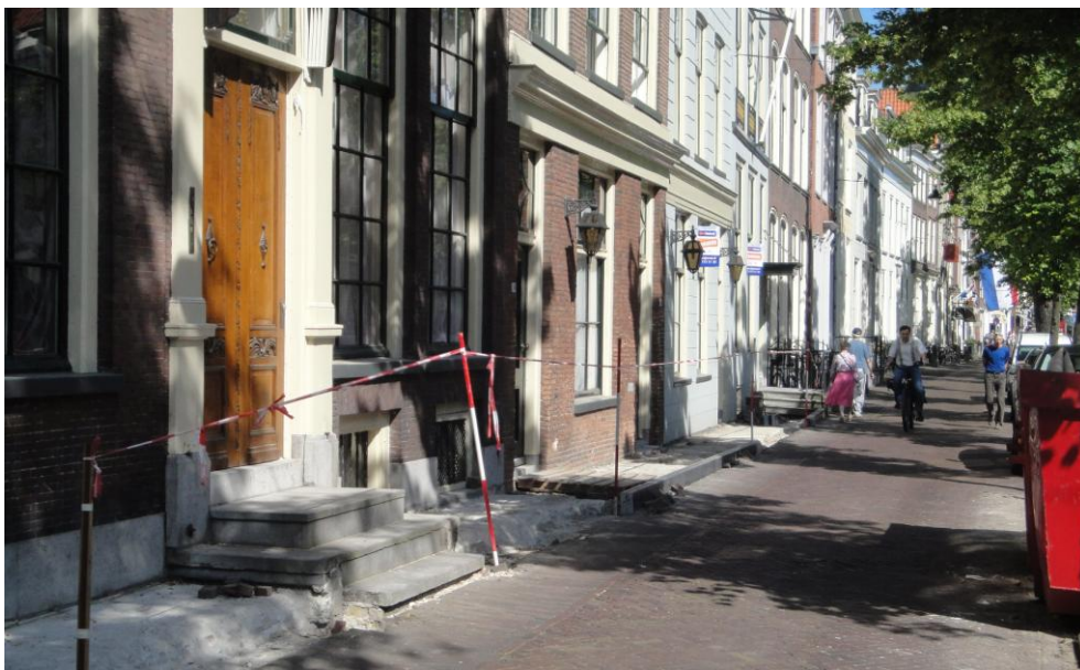
Na de illegale sloop. Foto: Tammo Remmerswaal
