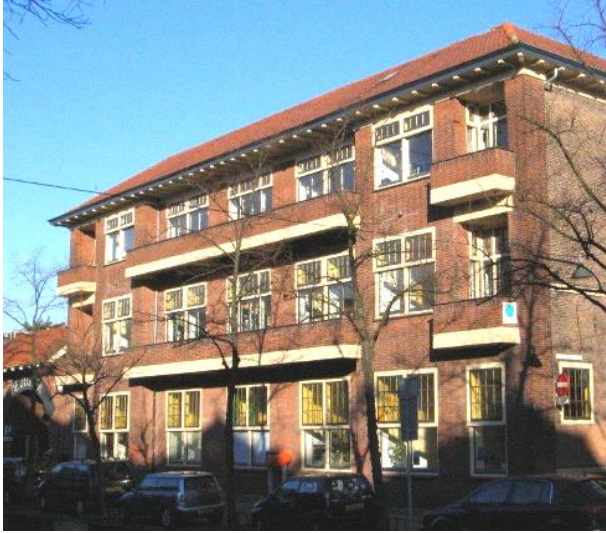
Nominatie 1: Gasthuis BV, voor de gevelrenovatie (schilderwerk) van het voormalig zusterhuis Koornmarkt 10, nu bedrijfsverzamelgebouw 'De Zuster'.
