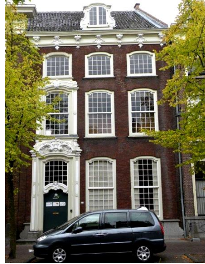
Nominatie 2: De heer T. Deelstra (Stichting De Witte Roos), voor de gevelrestauratie van Oude Delft 73, met reconstructie van het lijstwerk van de deur.
