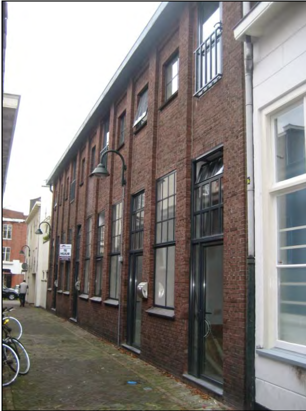
De nieuwe situatie .....na jaren aandringen tòch nog Franse balkons in de Nickersteeg
