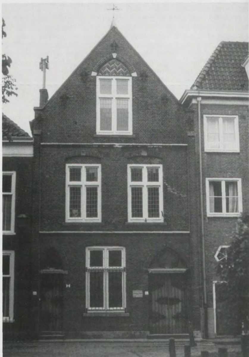
7. De voorgevel van de Oud-Katholieke Kerk aan het Bagijnhof vertoonde twee eeuwen lang op geen enkele wijze, dat er een kerk achter verscholen ging. Daarna werd bij de restauratie van 1870 alleen door een bijzondere uitvoering van de beide deuren uiting gegeven aan het feit, dat het hier niet een eenvoudig woonhuis betref.
