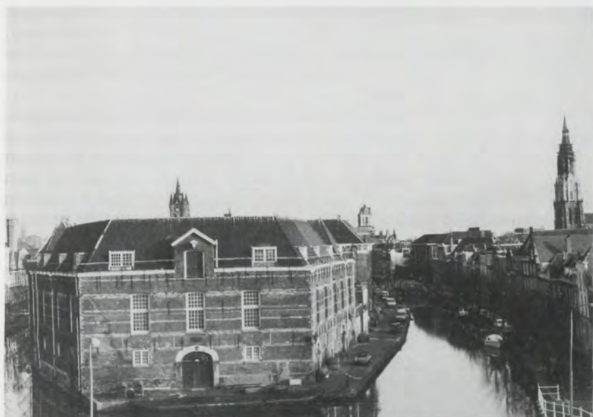
2. Foto van het Armamentarium te Delft. De foto werd gemaakt vanaf een hoogwerker staande op de Zuidwal, waar vroeger de Schiedamse Poort stond. De torens van de Oude Kerk, het Stadhuis en de Nieuwe Kerk zijn duidelijk zichtbaar. (Foto afkomstig van ir. K. Havinga, Openbare Werken Delft , omstreeks 1987).
