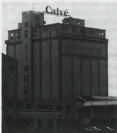
5. Het silogebouw in 1994. Het hoge gebouw op de voorgrond is het in 1905 gebouwde voormalige oliepakhuys (foto: Dienst Stadsonwikkeling).
