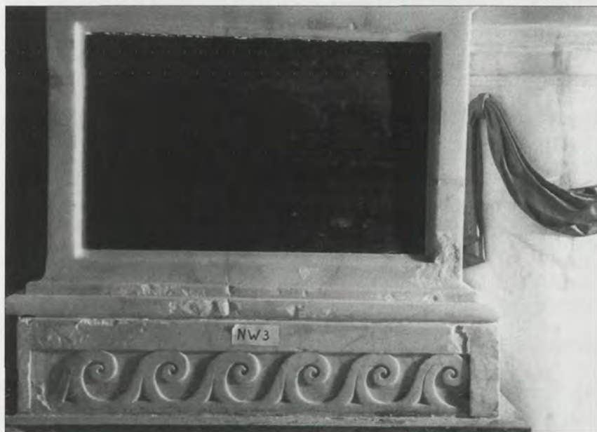
Op deze detailfoto is de zoutschade goed te zien (foto Rijksgebouwendienst).
