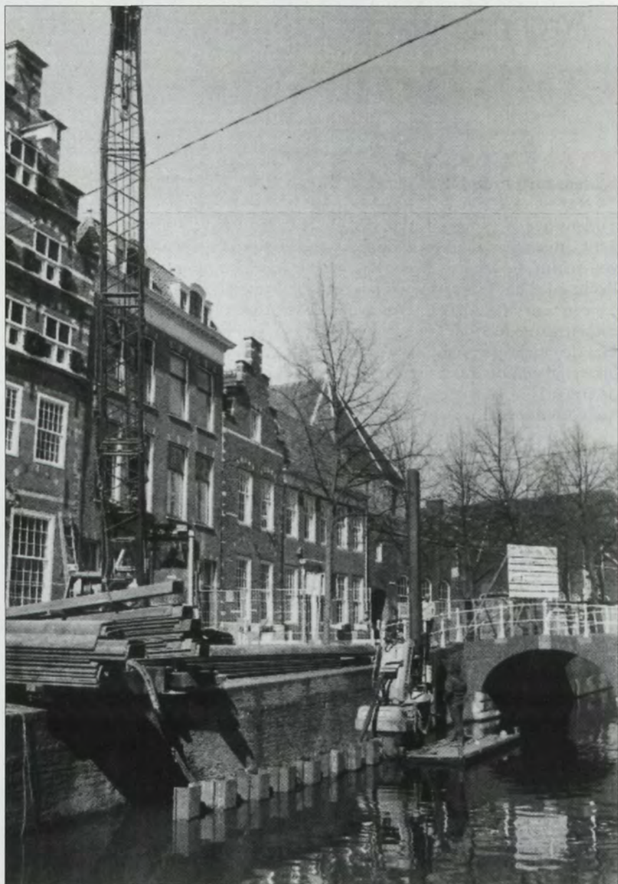
Het vervangen van de kademuur aan de Oude Delft bij het Gemeenlandshuis van Delfland.
