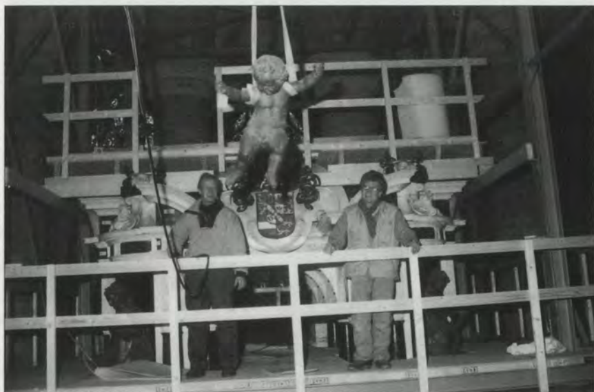
Werkplatforms in de staalconstructie.
