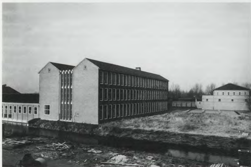
Het nieuwe gebouw aan het Westplantsoen in aanbouw, najaar 1956.
