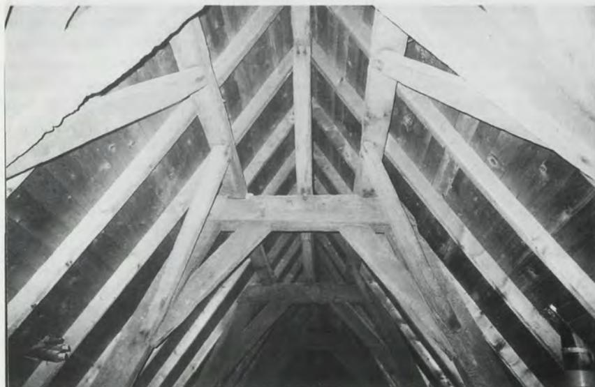
Originele eiken kapconstructie uit de 16e eeuw in een van de panden aan de Wijnhaven.
