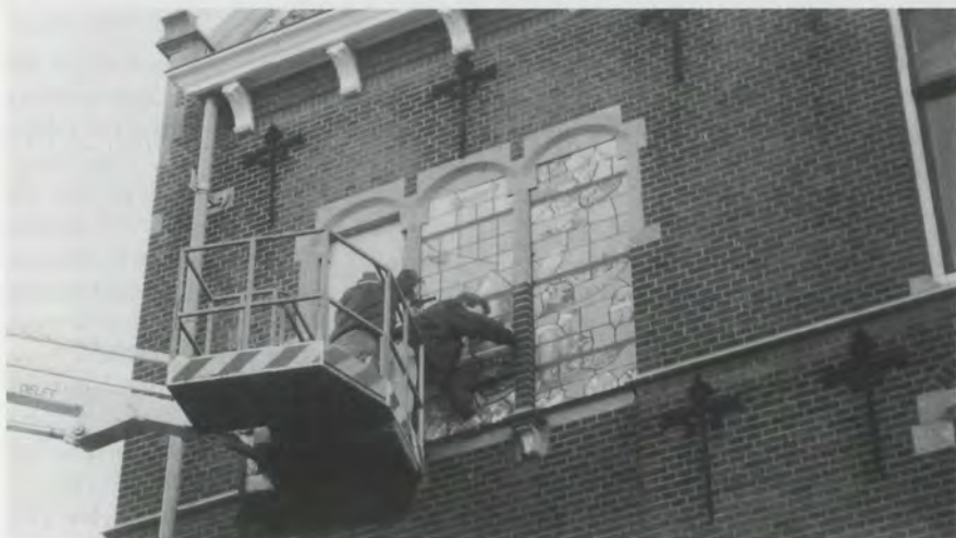
Op 20 december 2000 werden de panelen aan de gevel aangebracht (foto: W.F. Weve).
