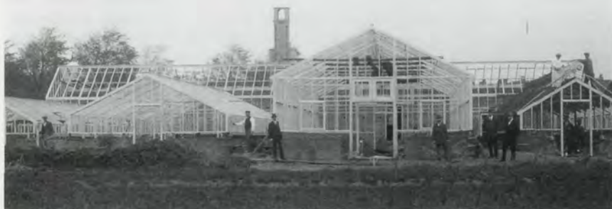
Kassen in aanbouw, 1916/1917
