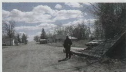
Whited Avenue in zuidelijke richting. Op de voorgrond de restanten van de kruidenierswinkel. Verderop stonden de ijzerwarenwinkel, het postkantoor en de bank.
