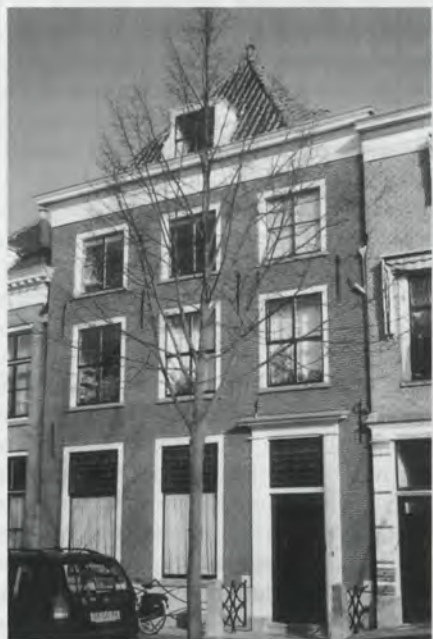
De voorgevel van Oude Delft 210 was van een oude afwerking voorzien met een geschilderd voegenpatroon. Bij de reparatie van de gevel is dit weer in ere hersteld (foto: W.F. Weve).
