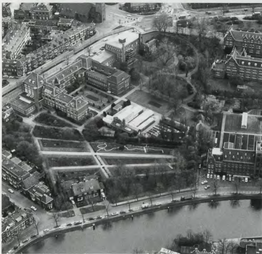
Luchtfoto van de tuin, zeventiger jaren. Links het laboratorium met de twee nieuwe vleugels. Tussen de twee parallelle vleugels ontstond de rechthoekige middentuin. De bomentuin is te herkennen aan zijn gebogen paden. Rechts de gebouwen van Mijnbouw en Geodesie, waartussen de proeftuin, die later zou overgaan naar Rijkswaterstaat die in het Geodesiegebouw trok. In het midden de kassen, gerenoveerd en deels verhoogd in 1950-1954. Onder de kruidentuin. Linksonder de Botaniestraat.
