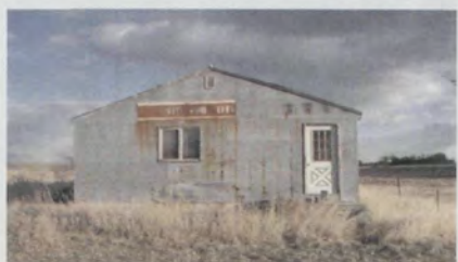
De voormalige elevator. Op het rode bord is te lezen "Delft Coop Elev".
