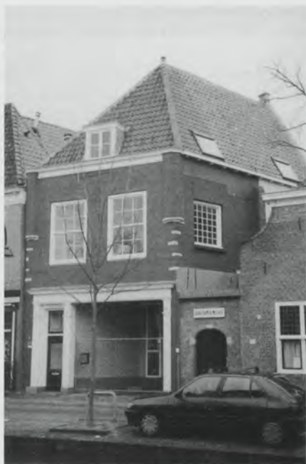
Oosteinde 173 toont met zijn boektorentjes nog iets van het oorspronkelijke middeleeuwse karakter. Het zeer verwaarloosde pand werd zorgvuldig hersteld foto: W.F. Weve).
