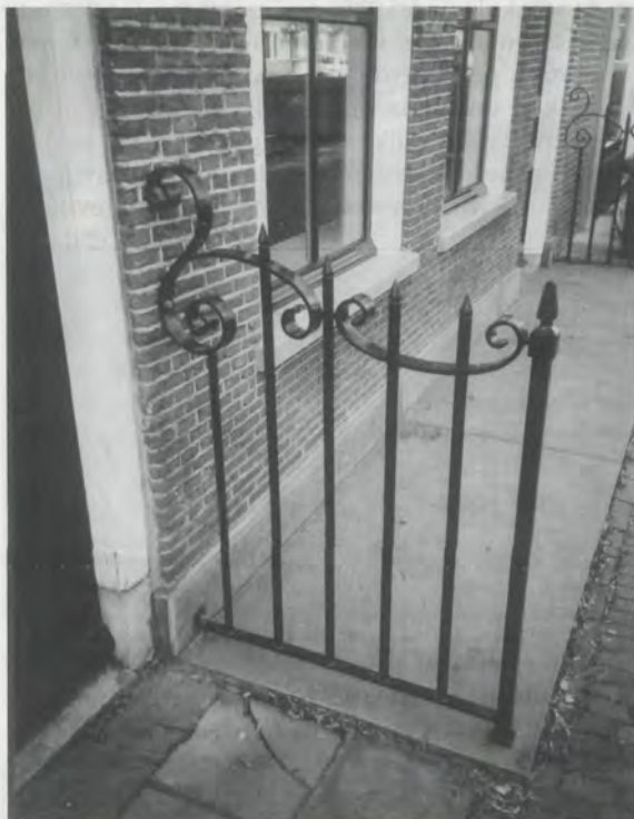
Bij de reconstructie van de stoep van Oost-einde 17 werden weer smeedijzeren hekjes in achttiende-eeuwse vorm aangebracht. (foto Gem. Delft, vakteam MBK)
