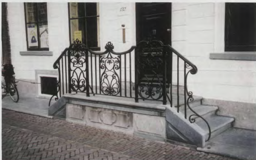
De gerestaureerde stoep van Oude Delft 132. Enkele natuurstenen onderdelen zijn vervangen en het ijzerwerk is gecompleteerd en hersteld. (foto Gem. Delft, vakteam MBK)
