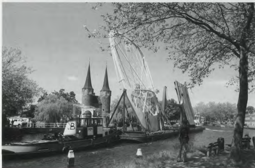
De Kolenbavenbrug vaart langs de Oostpoort (Foto: Fred Nijs).
