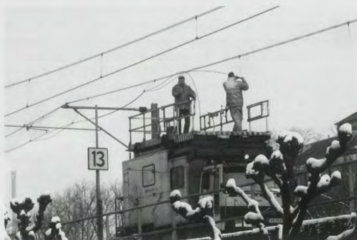
Reparatie van de kapotte bovenleiding (Foto: Fred Nijs).
