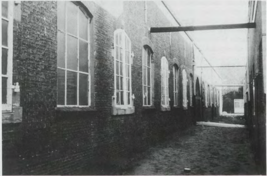
3. De oorspronkelijke vensters hadden natuurstenen onderdorpels en natuurstenen blokjes waarin de gebogen waren bevestigd van luiken of draairamen. Tussen deze vensters zijn later vensters toegevoegd zonder natuurstenen onderdelen (Foto: PuZa/MBK).
