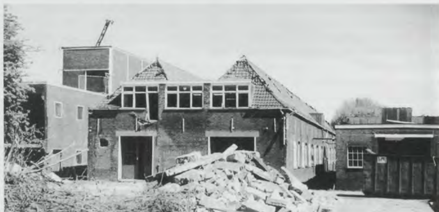
5. Het salpetermagazijn werd in 1999 gesloopt. Het kleine gat links in de westelijke kopgevel geeft aan waar de gevelsteen met het jaartal 1770 heeft gezeten. De dakkapel was aangebracht voor de kantine van de verffabriek (Foto: PuZa/MBK).
