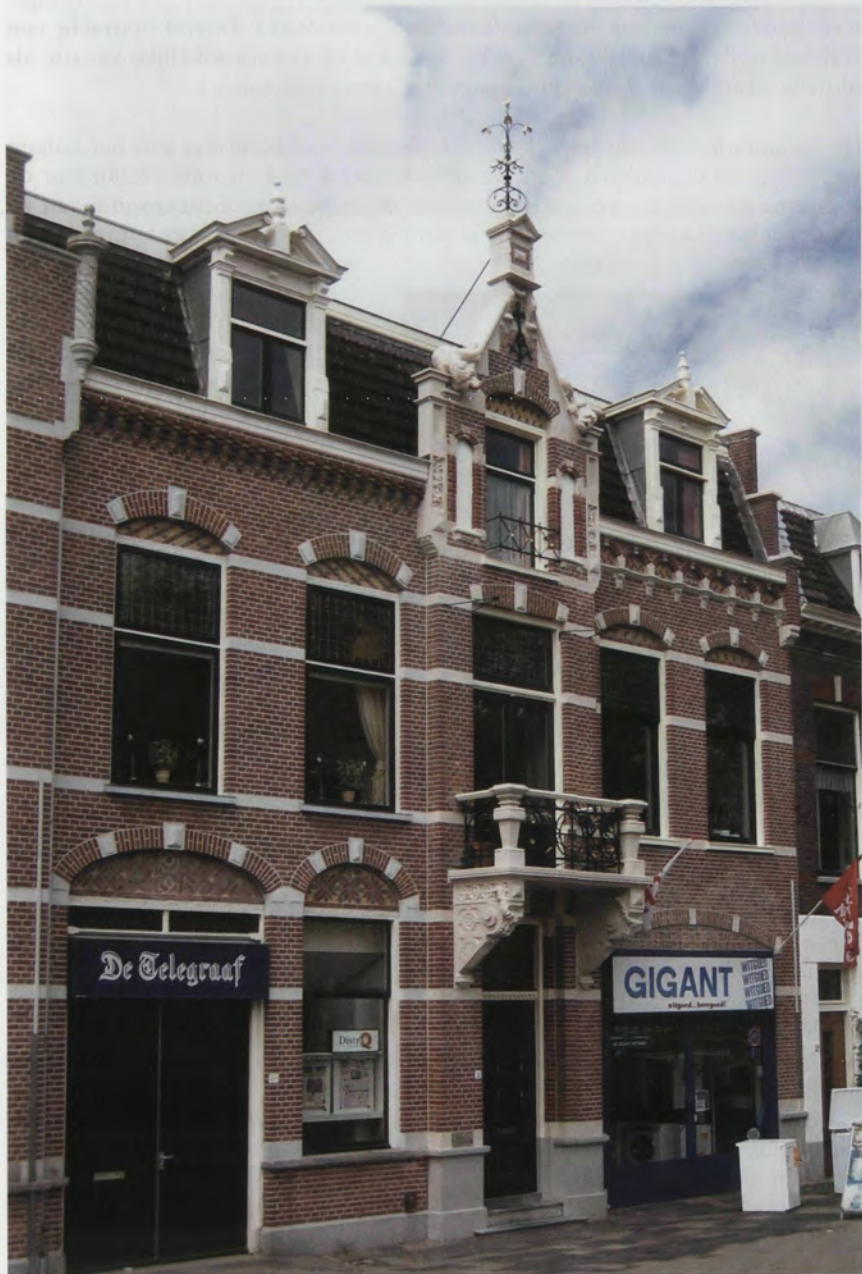
Spoorzingel 2 na de restauratie.
