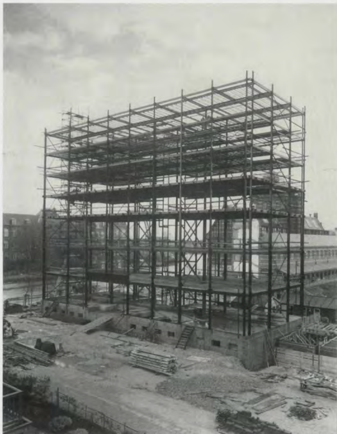
Het staalskelet van het nieuwe ITC-gebouw (Foto: Archief ITC).
