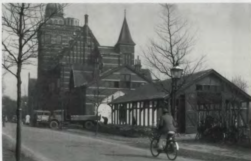
De sloop van de oude gebouwen naast het gebouw voor Geodesie aan de Kanaalweg (Foto: Archief ITC).
