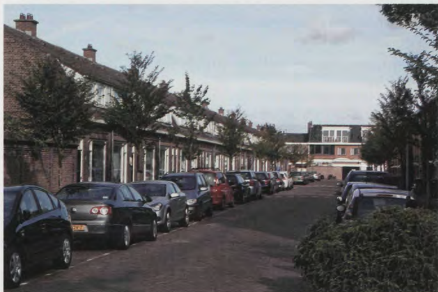
De Jan de Wittstraat na de renovatie (Foto: René van der Krogt).
