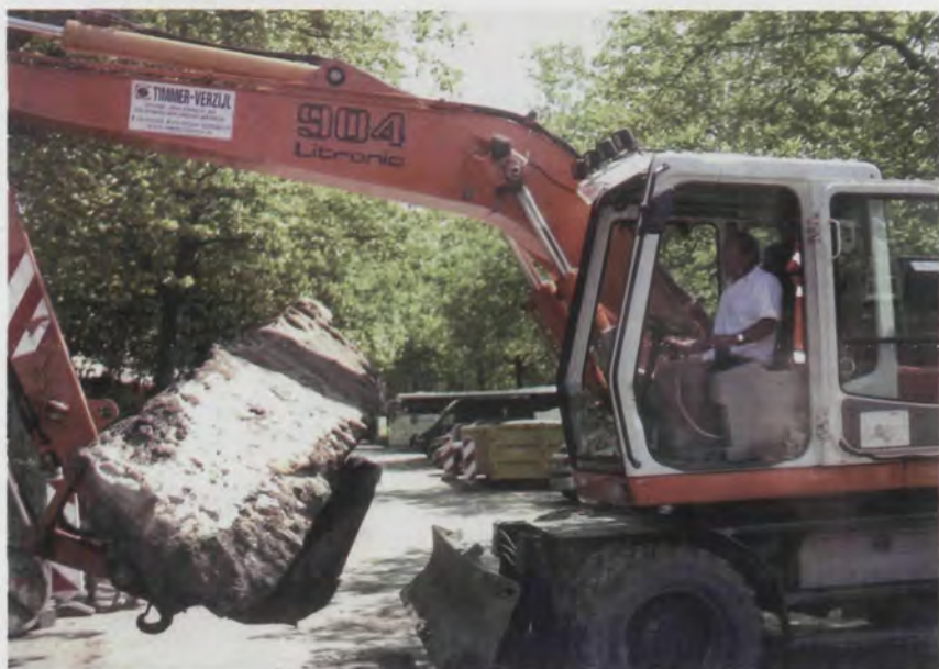
4. Een deel van de zware kademuur van de Raamgracht. Mogelijk behoort de kern van deze kade tot de fundering van een gebouw van vóór de Delftse Donderslag in 1654 (Foto: Erfgoed Delft Archeologie).
