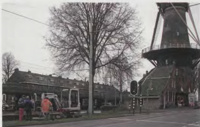
5. Werkzaamheden ter hoogte van werkput 2, gezien vanuit het zuidoosten (Foto: Erfgoed Delft Archeologie).
