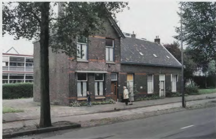
Het huis op de Rotterdamseweg nr. 141-143, de vroegere veldwachterswoning is omstreeks het jaar 2000 afgebroken. Tegenwoordig staat er de nieuwbouw van de Hogeschool INHolland (Foto: familie Van Oosten).
