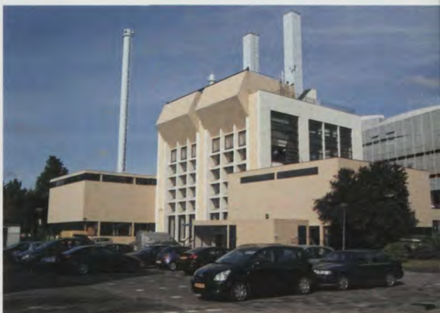
Het ketelhuis aan de Leegwaterstraat (Foto: René van der Krogt).
