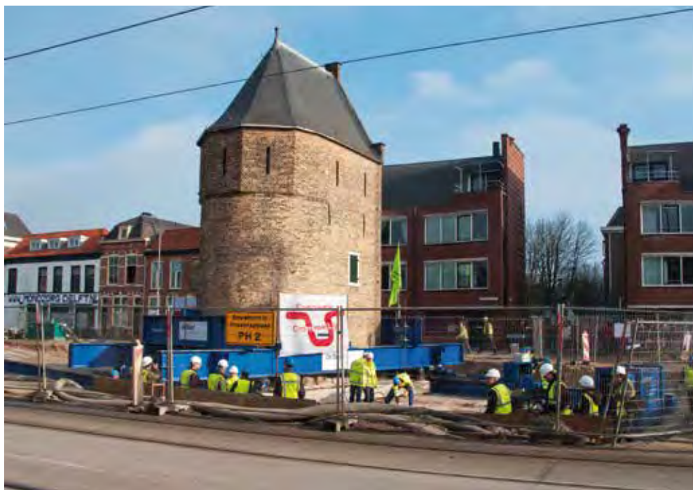
De Bagijnetoren schuift tijdelijk aan de kant voor de spoortunnel.
