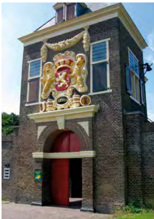
Gevelsteen na restauratie, 2011.
