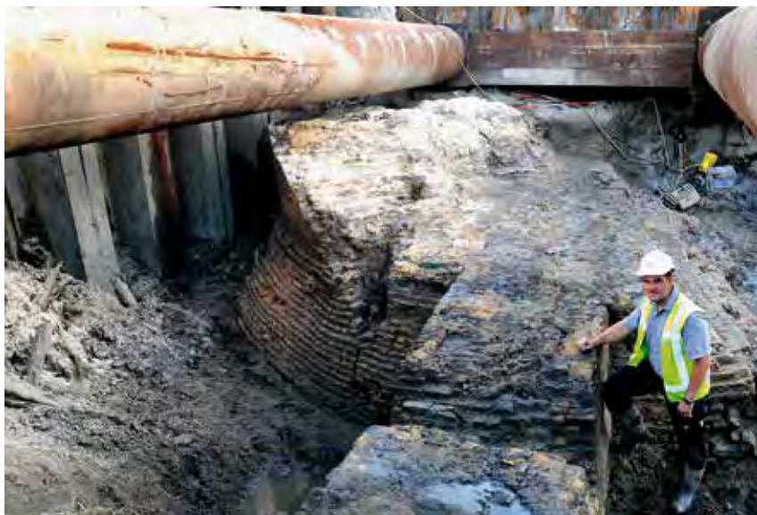
De funderingen van de Waterslootse Poort komen aan het licht.
