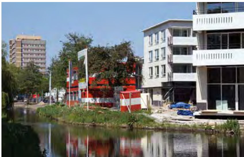
De renovatie en nieuwbouw van de Bomenwijk is in volle gang.
