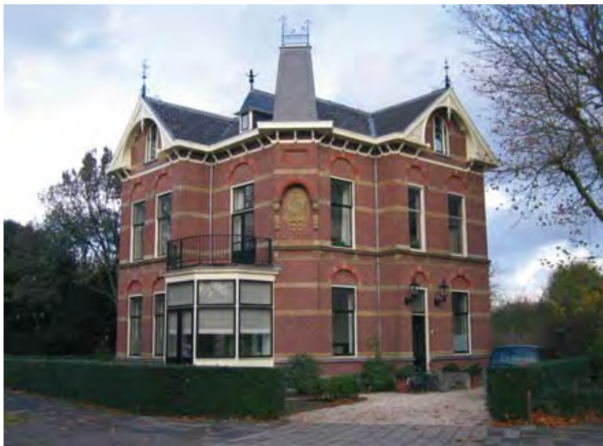
Villa Maria aan de Oostsingel (Foto auteur).
