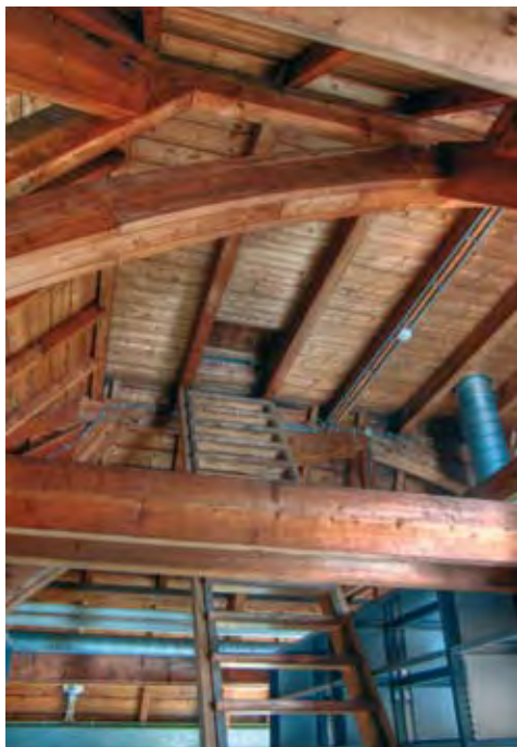
De kapconstructie (centrale deel) (Foto: René van der Krogt).
