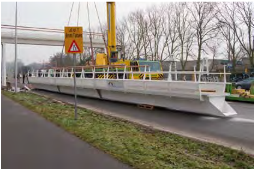
De nieuwe loopbrug geplaatst, 18 december (Foto: René van der Krogt).
