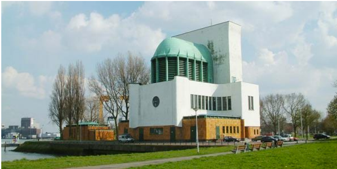
Een van de ventilatiegebouwen van de Maastunnel (architect Ard van der Steur, 1893-1953)
