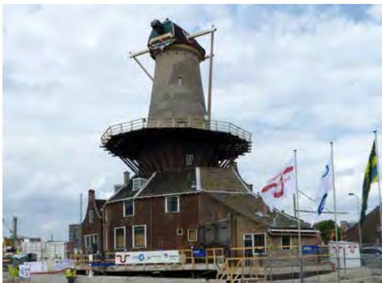
Het opvijzelen van de molen verloopt secuur en voorspoedig.
