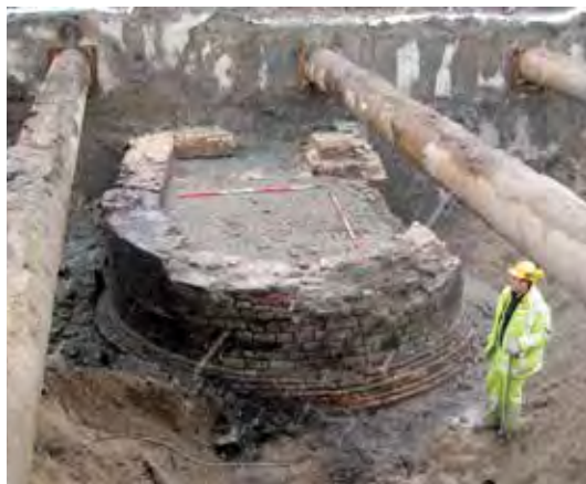
18. Funderingen van de Michielstoren, een waltoren uit de late vijftiende eeuw. Het vloerniveau stamt uit een latere fase van hergebruik als kelder bij een woning.
