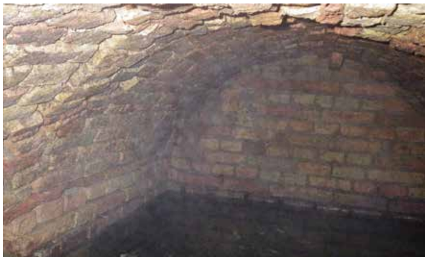
8. De kelder onder de Rotterdamse poort aan de binnenzijde in noordelijke richting
