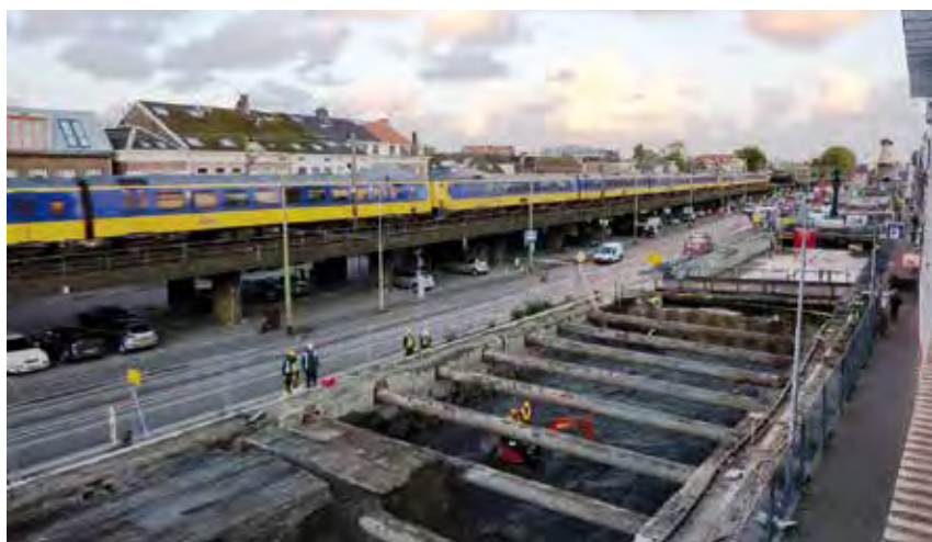
13. De bouw van de eerste tunnelbuis langs het bestaande spoorviaduct. Aan de rechterkant de binnenstad van Delft, in de verte de Bagijnstoren en de stellingmolen De Roos.
