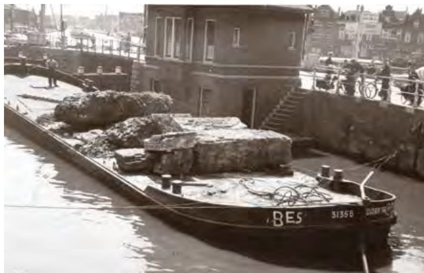
7. Het verwijderen van de fundering van de poorttoren van de Rotterdamse poort in 1960 en van de voorpoort, aan de overkant van de Schie, in 1979. Bron: Archief Delft.
