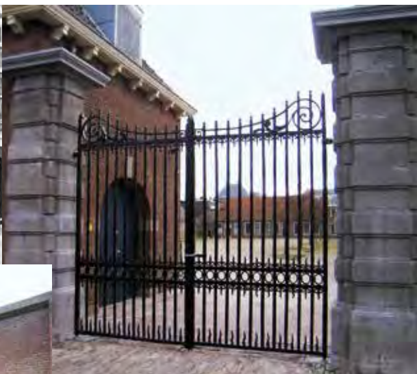
Het herplaatste hek met zicht op de binnenplaats.
