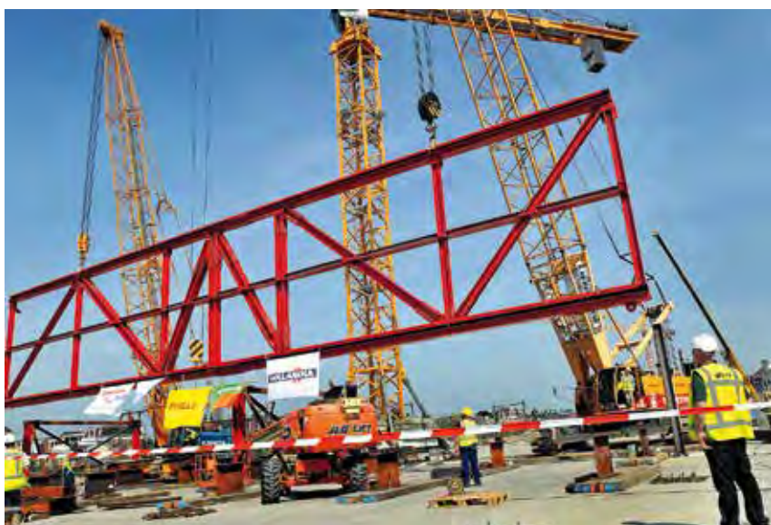
Met de eerste spant start de bouw van het nieuwe stadskantoor.
