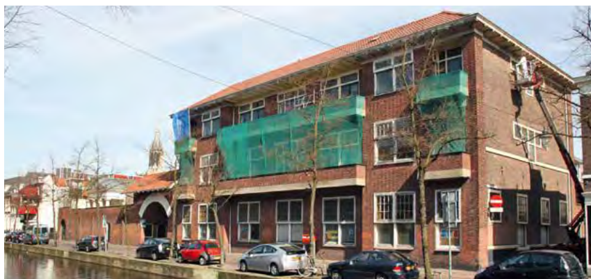
Situatie tijdens de werkzaamheden (27 maart 2012).
