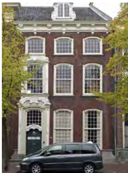
Totaalfoto van de gevel met de deur in de oude situatie.
